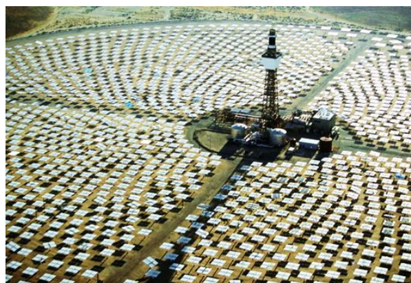
参考写真:ヘリオスタットを活用したタワー式太陽熱発電プラント(ソーラータワーを中心に、集光を担う多くのヘリオスタットが配置される)
